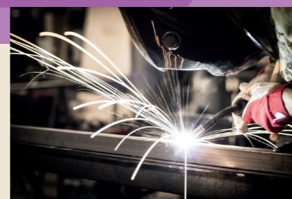
Lassen / Puntlassen / Studlassen
